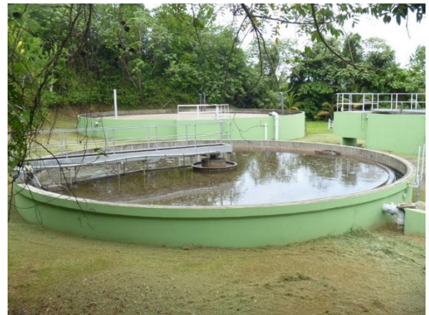
Figure 2.3 – Filière 2 : clarificateur
