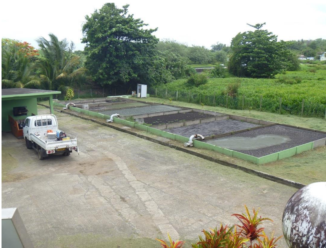
Figure 1.1 - Lits de séchage
