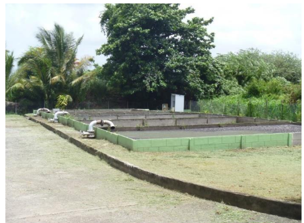
Figure 2.5 – Lits de séchage des boues
