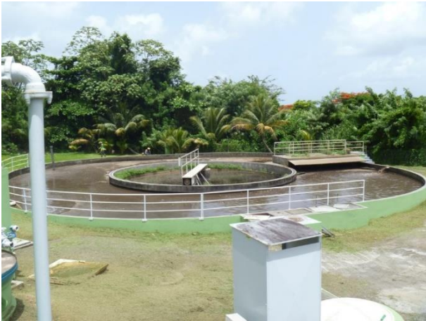
Figure 2.1 – Filière 1 : aération + clarificateur
