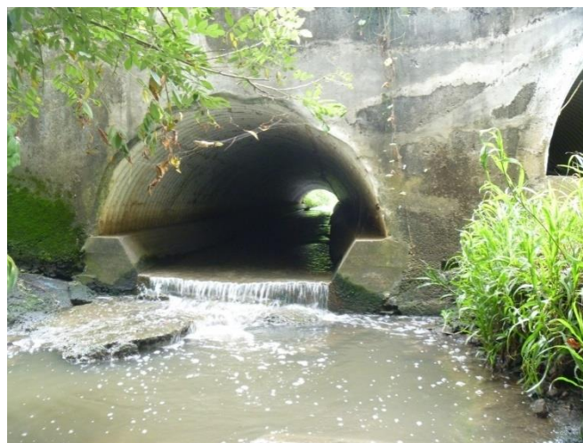
Figure 3.13 - Ré-oxygénation des eaux en aval du seuil (sous la Rn5)
